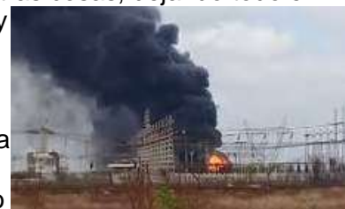
Un incendio en una subestación eléctrica en la zona industrial de nuestra ciudad el año pasado.
